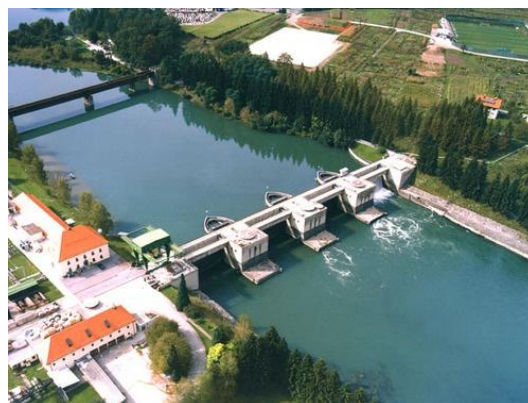
Slika 5: HE Dravograd kot primer pretočne hidroelektrarne (Vir: http://www.hse.si/615 , 28. 5. 2011)
