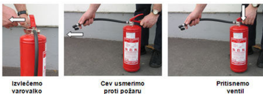
Slika 48: Aktiviranje gasilnika S6, ki je pod stalnim tlakom
