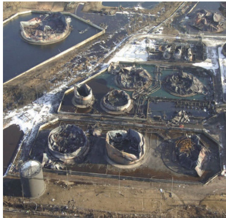
Slika 1: Skladišče po požaru Vir: Hvala, 2009
