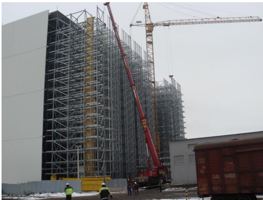
Slika 21: Gradnja oblečenega avtomatiziranega skladišča Vir: http://niko-ru.com/rubez_en.htm#rubez (14. 3. 2011)
