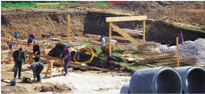
Slika 24: Izkop gradbene jame
