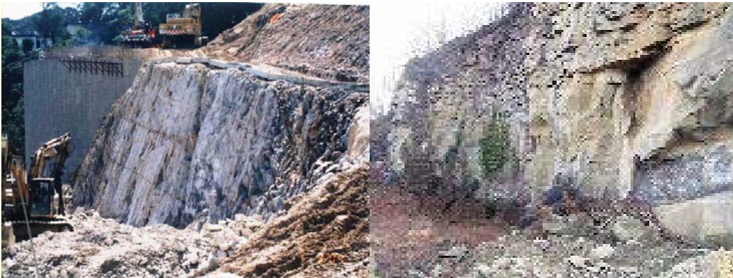
Slika 30: Primerjava med gladkostjo brežine izdelane s pomočjo pre-splitting metode in brez nje
