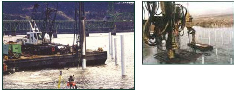
Slika 41: Splav, opremljen za podvodno vrtanje
