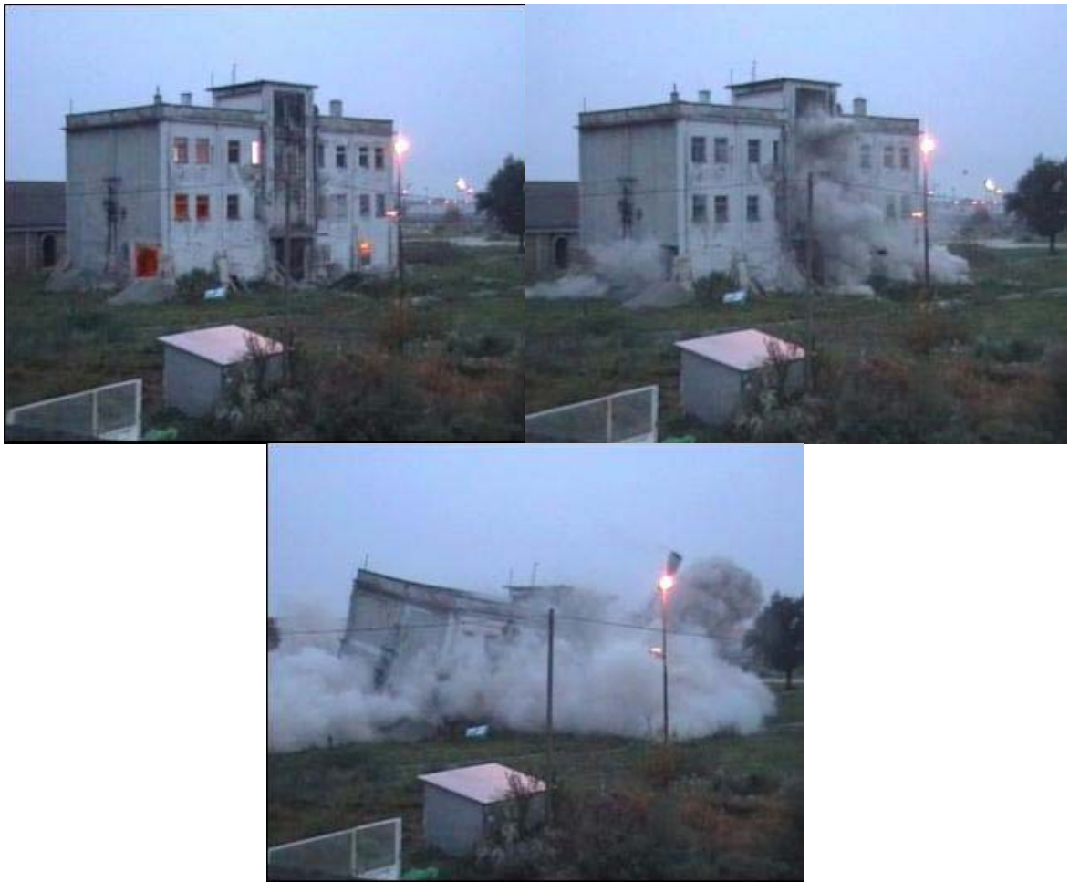
Slika 34: Potek porušitve zidov Vir: Božić, 1998, str. 145
