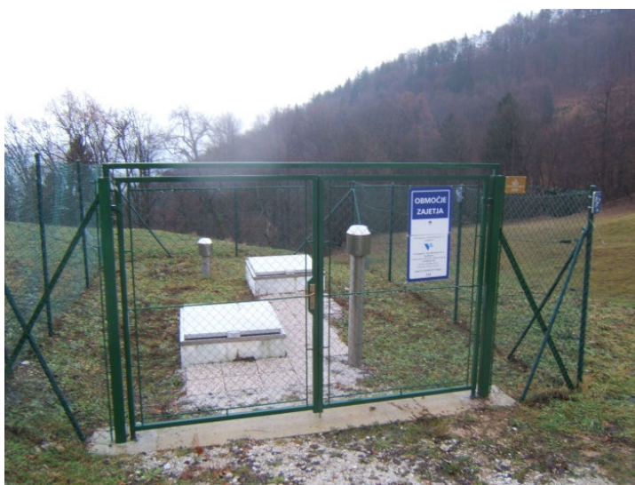
Slika 47: Preprosto črpališče z vrtanim vodnjakom Vir: Lasten
