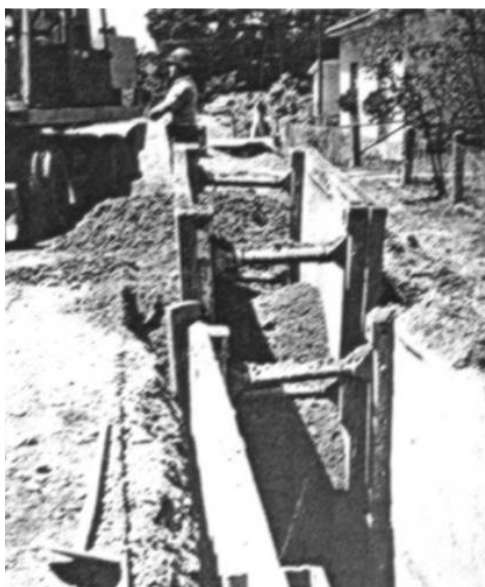
Slika 89: Varno polaganje cevi v izkopenem jarku z razpiranjem Vir: Lasten
