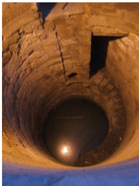
Slika 41: Kopani vodnjak (obzidava s kamni) Vir: Lasten
