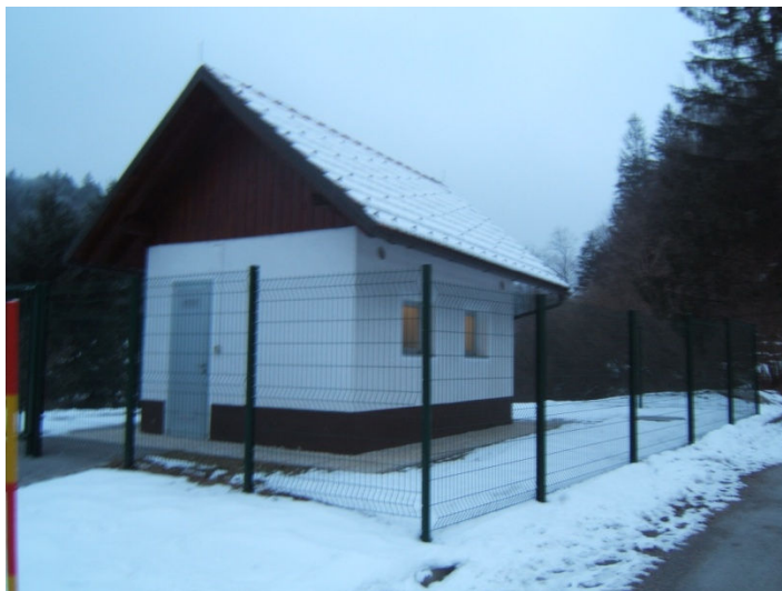
Slika 48: Preprosto črpališče z vrtanim vodnjakom Vir: Lasten
