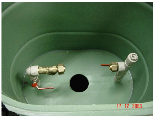
Slika 75: Montažni vodomerni jašek vodovodnega priključka Vir: Lasten
