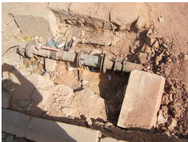
Slika 63: Fazonski kosi (vgrajeni v nerazvitem svetu ob zasunu) Vir: Lasten
