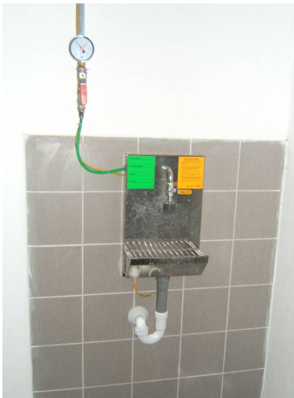
Slika 4: Pipa za odvzem vzorcev v vodarni Vir: Lasten
