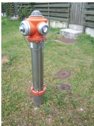
Slika 70: Nadzemni hidrant Vir: Lasten
