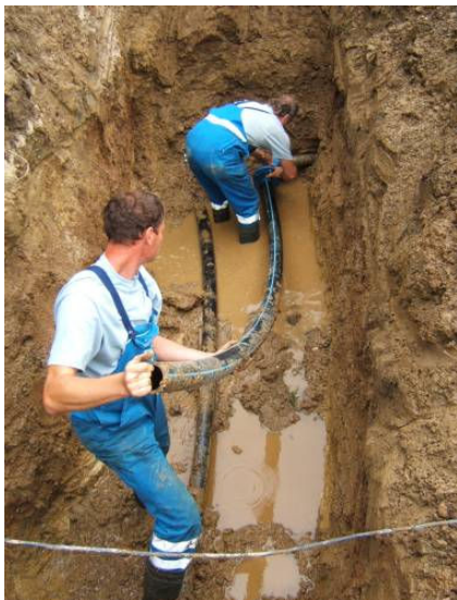
Slika 97: Zamenjava počene cevi vodovoda Vir: Lasten
