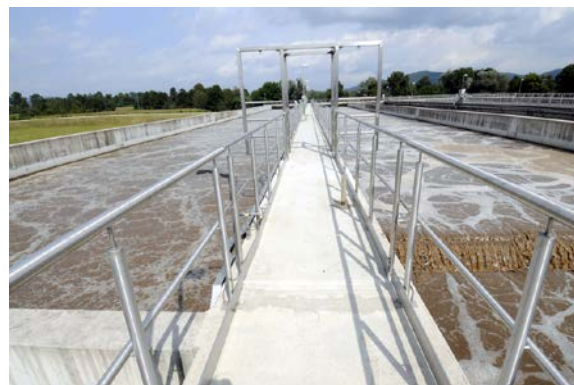
Slika 5: Prikaz aeracijskega dela čistilne naprave Ljubljana
