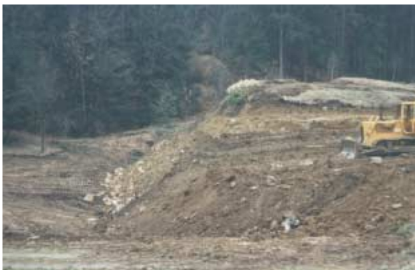
Slika 11/10: Sanacija zemljišča z izravnavo degradiranih površin
