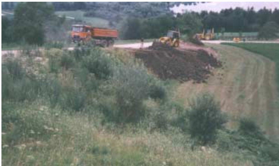
Slika 11/11: Sanacija degradiranega zemljišča z navozom materiala
