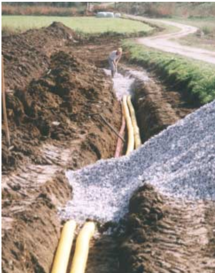
Slika 11/12: Postopek drenažiranja zemljišča
