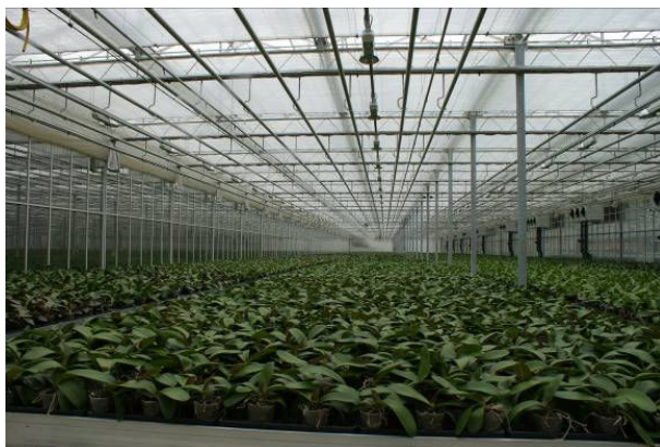
Slika 2: Svetila 600W natrijeve visokotlačne žarnice – 5000 LUX (podjetje Ocean Orchids) Vir: Lasten
