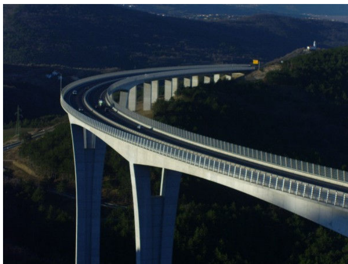
Slika 34: Viadukt Črni Kal
