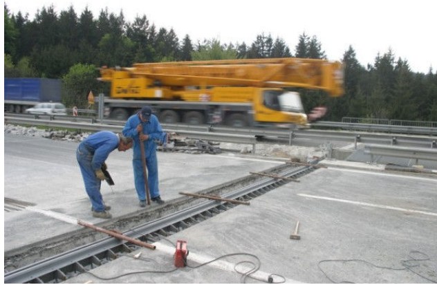
Slika 21: Gradnja hitre ceste čez Rebrnice
