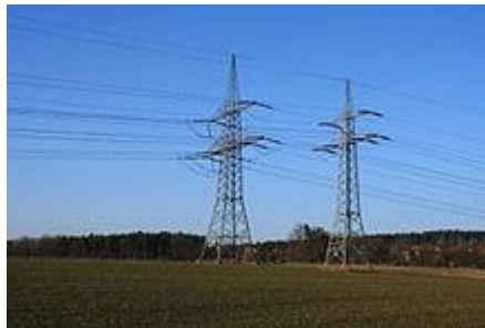
Abb. 18: Größenvergleich zwischen einem 220-kV-Masten und einem 110-kV-Masten Quelle: http://de.wikipedia.org/wiki/Freileitung 23. 3. 2011
