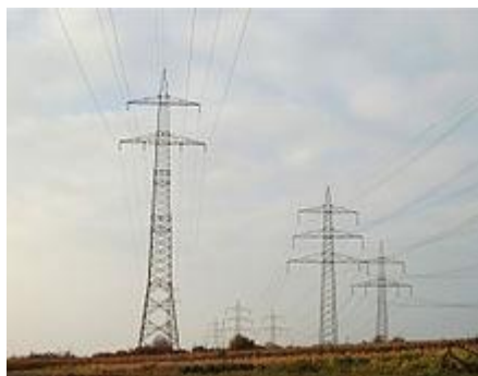
Abb. 17: Freileitungsmasten mit verschiedenen Freileitungsarten
