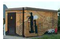
Eine künstlerisch gestaltete Trafostation
