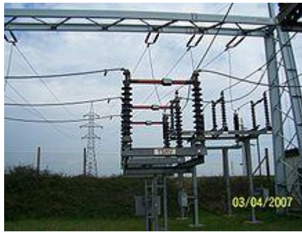
Abb. 14: Trennschalter für 110 kV in einer Schaltanlage
