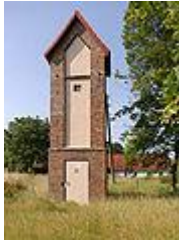
Turmtrafostation im ländlichen Raum
