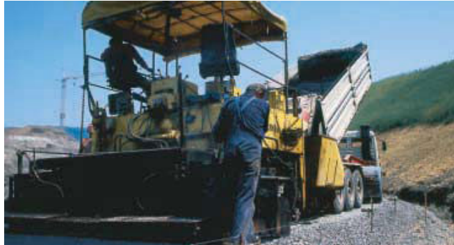
Unter Abb. 17: Baumaschinen
