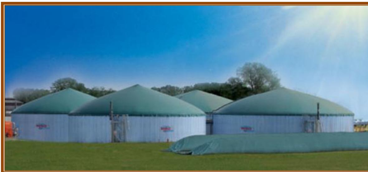
Slika 70: Postavljeni digestorji s plinotesno zaprtimi kupolami Vir: Jejčič s sod., 2009
