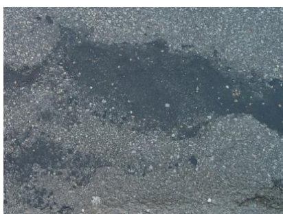
Slika 66: Zmanjševanje torne sposobnosti zaradi iztisnjene bitumenske malte
