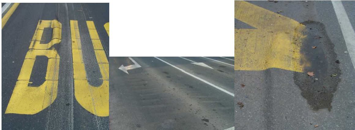
Slika 65: Kolesnica (levo), perilnik (sredina), grbina (desno)
