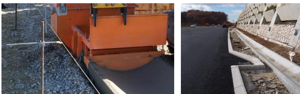
Slika 25: Strojno vgrajevanje mulde širine 82 cm na avtocestnem odseku s strojem GOMACO GT-3600 (levo) in strojno izdelan robnik in mulda na AC Maribor – Lenart (desno)
