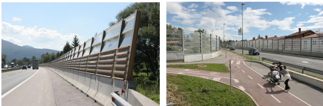
Slika 20: Kovinski protihrupni panel (levo) in t. i. žagasti protihrupni panel iz nerjaveče pločevine
