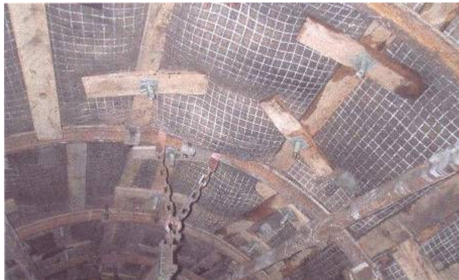
Slika 40: Proga, podgrajena z JLP in kompozitnimi sidri (redka tesarba)
