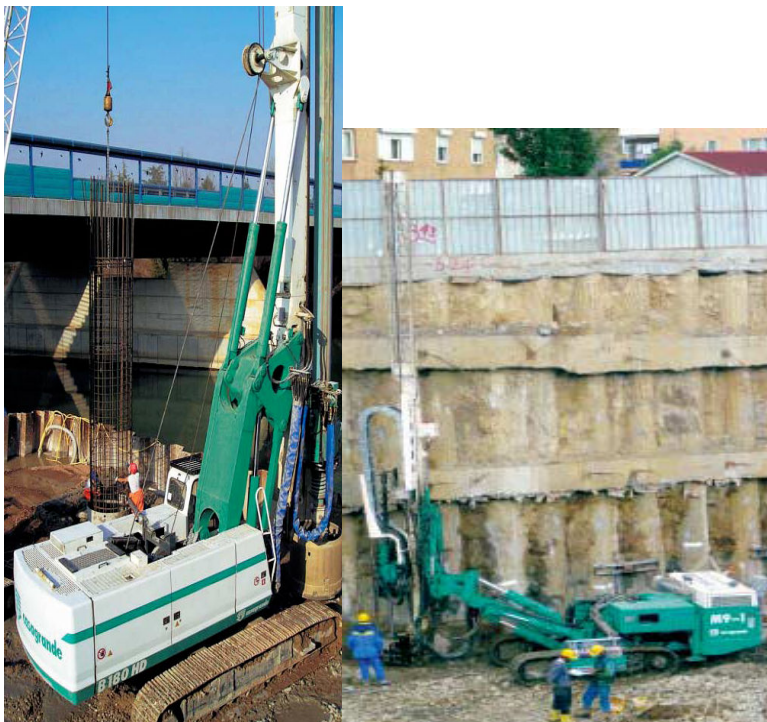
Slika 5: Vrtalna dela pri temeljenju
