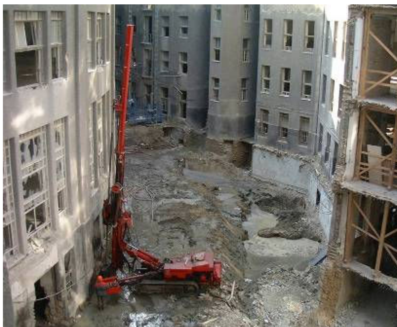
Slika 33: Jet grouting sistem injektiranja
