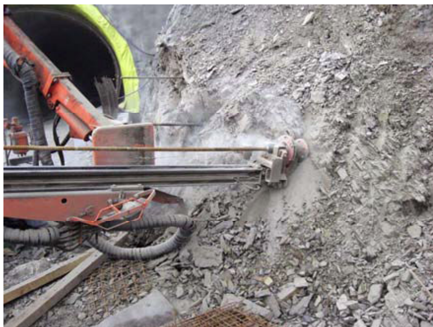
Slika 53: Vgradnja – uvrtnje pasivnega geotehničnega sidra
