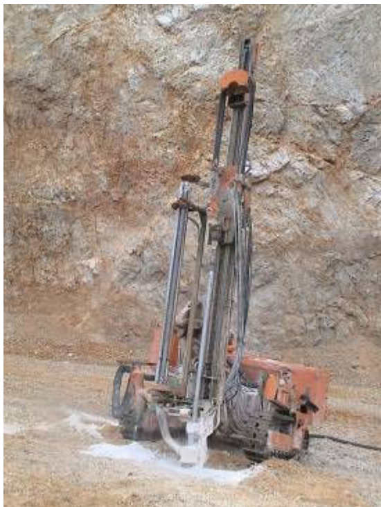
Slika 18: Vrtalno kladivo izven vrtine
