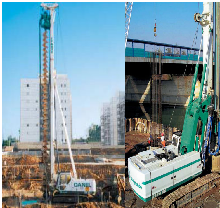
Slika 1: Vrtalna garnitura na delovišču
