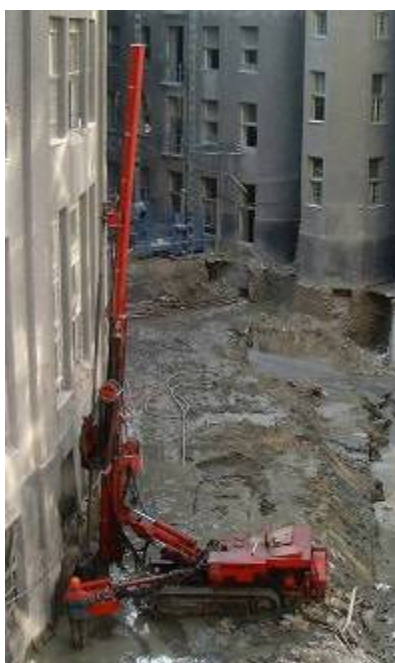
Slika 36: Vrtalni stroj pri tehnologiji jet grouting
