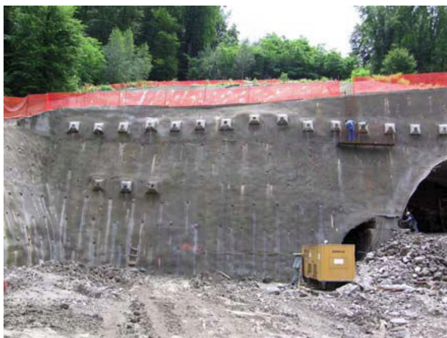
Slika 54: Primer varovanja predorskega portala s komb. pasivnih in prednapetih sider
