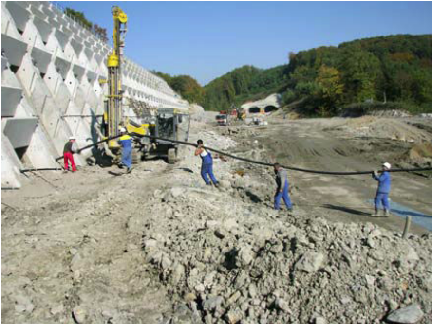
Slika 57: Vstavljanje sidra pri utrjevanju avtoceste (1 delavec na 3–4 m)
