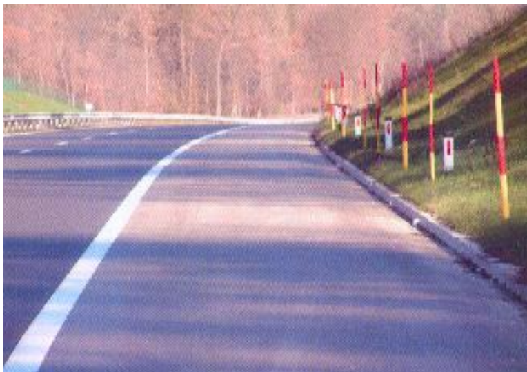
Slika 13: Postavitev snežnih kolov na avtocesti Vir: Lasten
