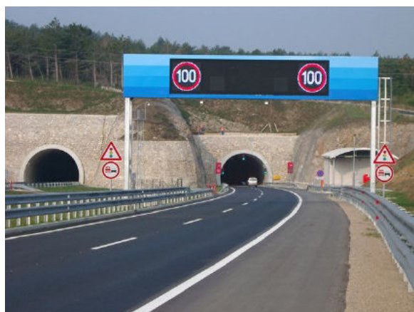
Slika 74: Informacijski portal na avtocesti
