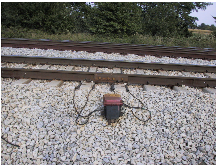
Slika 23: Električni priklop izolirnih mest
