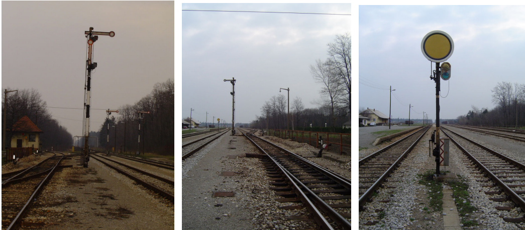
Slika 6: Mehanski (likovni) dvoročni in enoročni glavni signal ter predsignal
