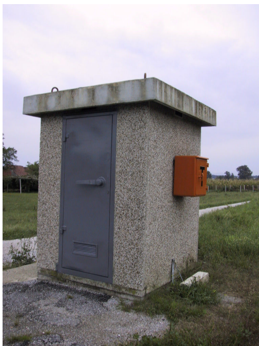
Slika 41: Hišica cestnega prehoda (HNPr)
