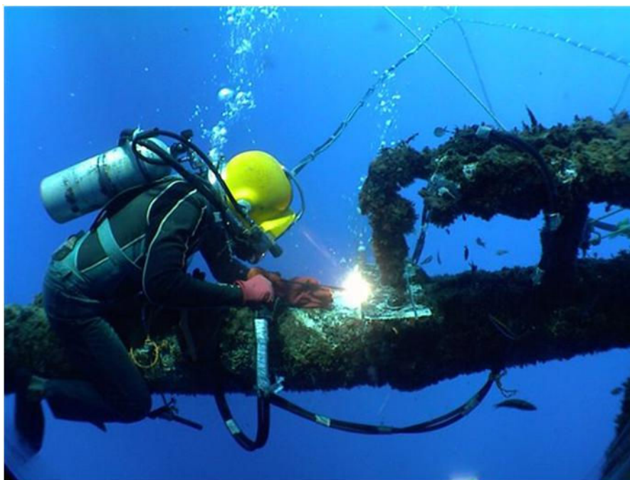
Slika 4: Podvodno varjenje
